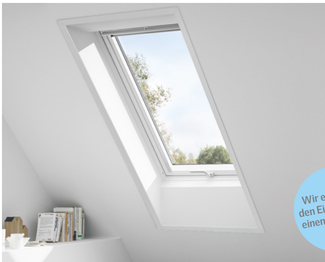
Fenster austausch mit neuer Innenverkleidung für einen erweiterten Lichteinfall.
