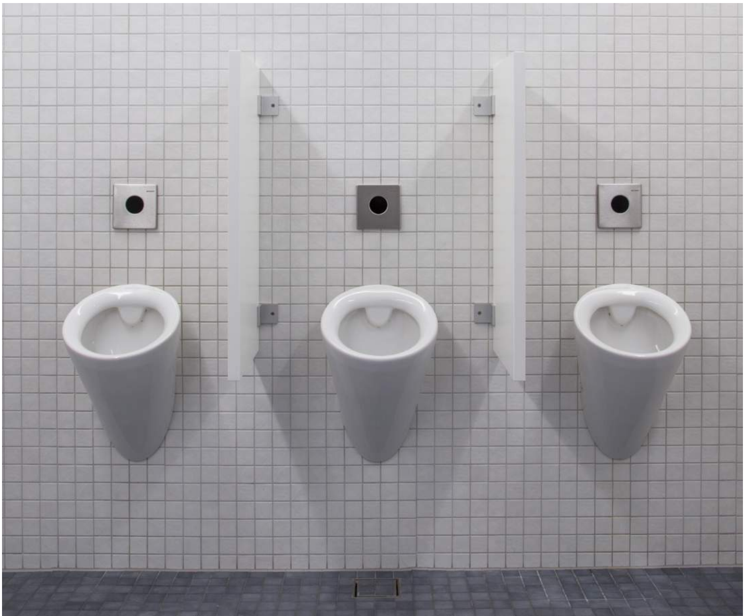
NiUU Urinaltrennwände in Verkehrsweiß 9217
