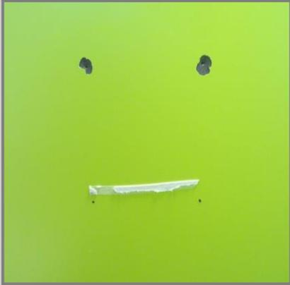
Ausgebrochene Befestigung eines bauseits befestigten Großrollenhalters (keine Einlagen in der Verbundplatte).
